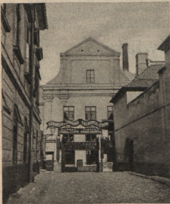
Kościół św. Benona i klasztor OO. Redemptorystów w Warszawie za czasów św. Klemensa. W czasach zaborczych była tu fabryka wyrobów stalowych. Zgromadzenie OO. Redemptorystów dąży do wykupienia tych pamiątkowych budynków.
