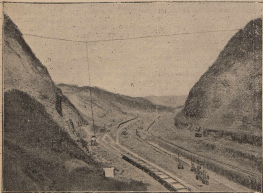
Budowa łożyska Kanalu wśród gór Kulebra.
