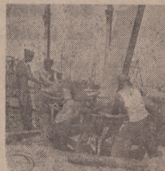
Rośnie budowa Nowej Huty. Na zdjęciu: przodująca brigada monterów Henryka Lachowicza z „Mościstalu 2” wykonująca przedpłatnie 200% normy i junacy SP z brigady nr 100 — ustawiają przy pomocy dźwigu słupy stalowe nowej hali, w której powstanie warsztat konstrukcji stalowych.
