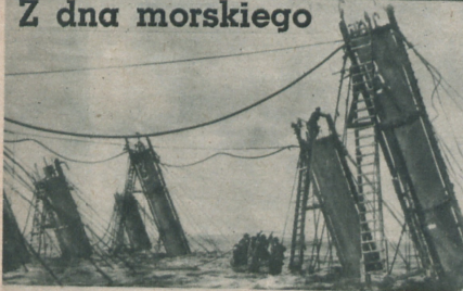
Widok na specjalne urządzenia na powierzchni morza, dzięki którym możliwe będzie podniesienie z dna niemieckiego okrętu liniowego "Kurfürst", zatopionego pod Scapa Flow.
