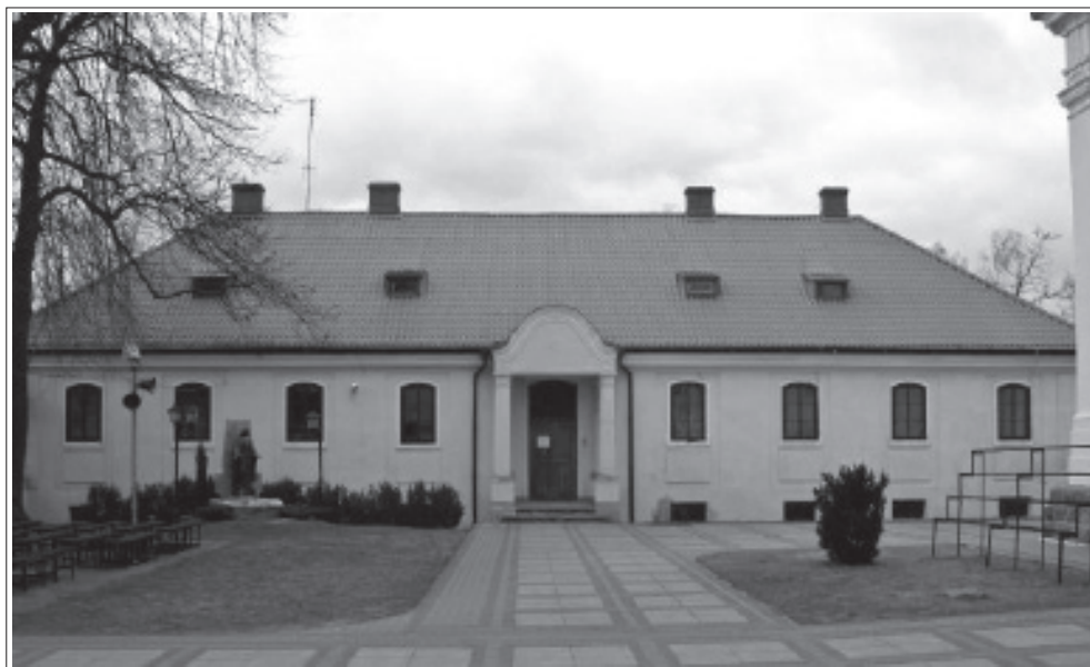
Fot. 14. Elewacja frontowa lubartowskiej plebanii przed przebudową, stan z 2008 r., fot. M. Filipowicz
