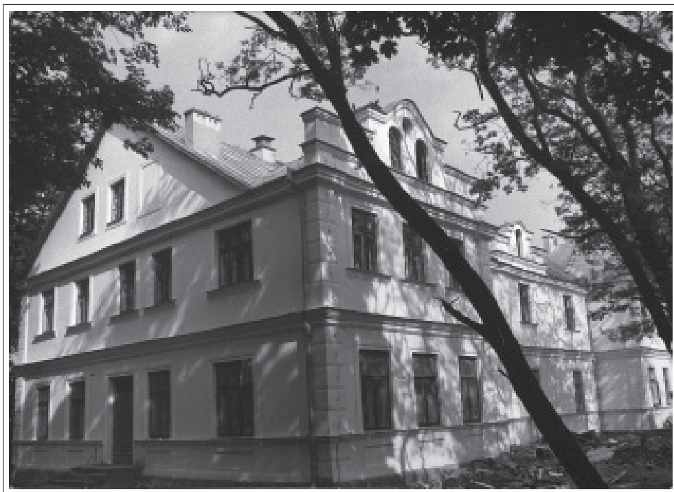
Fot. 5. Dawny szpital powiatowy w Lubartowie, w którym przed 1939 r. znajdował się przytułek dla starców i kalek kościelnych. Budynek zlokalizowano na rogu ul. Lipowej i ul. J. Słowackiego, 1996 r., zbiory Muzeum Ziemi Lubartowskiej
