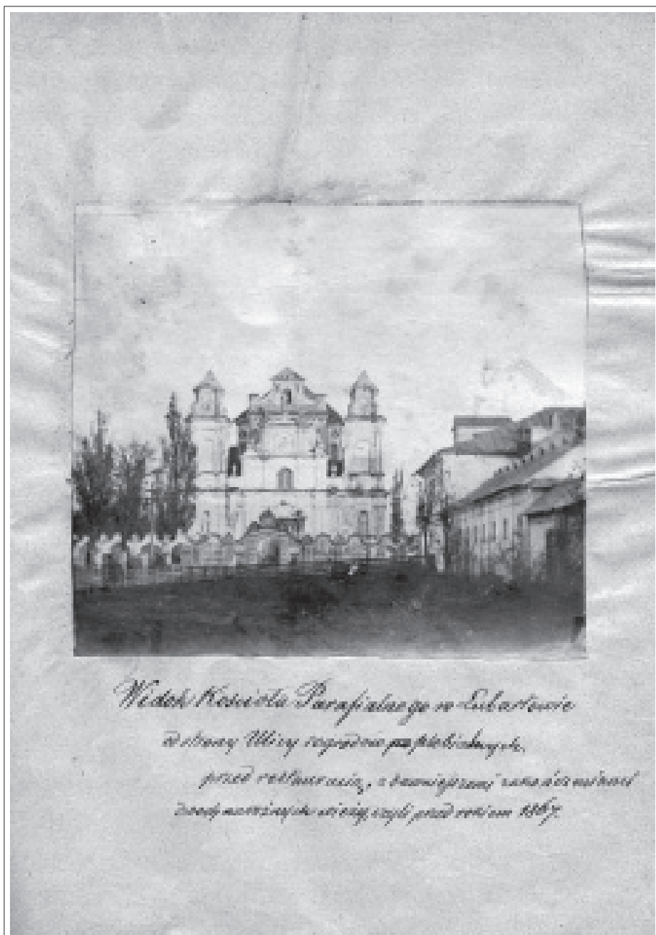
Fot. 3. Najstarsze zdjęcie kościoła parafialnego w Lubartowie wykonane przed restauracją świątyni. Widok od strony ulicy i ogrodów plebańskich, przed 1867 r., fot. G. Wereżyński. Zachowało się ono w zbiorach Archiwum Państwowym w Lublinie, zob. APL, Historyczne opisanie miasta Lubartowa na zasadzie oryginalnych dokumentów przez Gracjana Wereżyńskiego b. Rejenta Lubartowskiego, ukończone w dn. 24 XI 1885 r., sygn. 3360, s. 65
