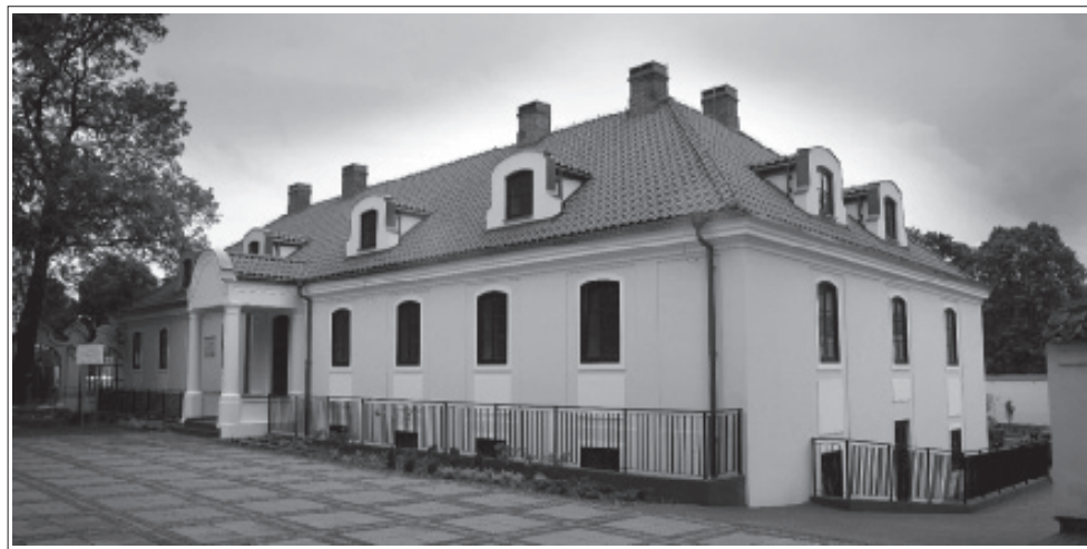
Fot. 16. Naroże południowo-wschodnie plebanii po przebudowie, stan z 2015 r., fot. J. Jusiak
