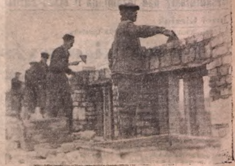
Brigada murarska Michała Stysia na bloku nr 5 ZOR—Zachód, realizuje zobowiązania na cześć II Zjazdu PZPR.
