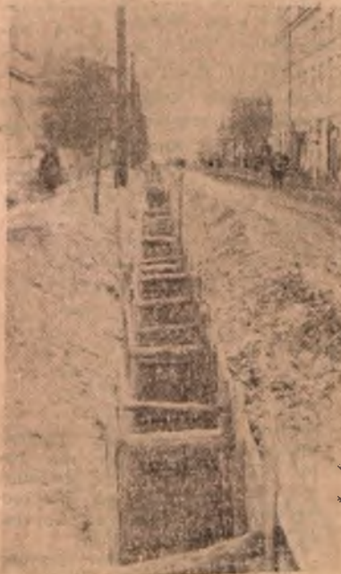
Wzdłuż głównej ulicy wyrzuca na boki ziemi i sterzące ponad powierzchnię jezdni deski i słupy szalunku znaczą spory odcinek wykopu.
