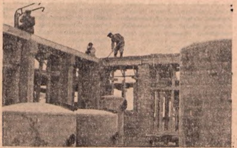
Fragment hali filtrów w budowanych obecnie Zakładach Oczyszczania Wody w Krasnymstawie.
