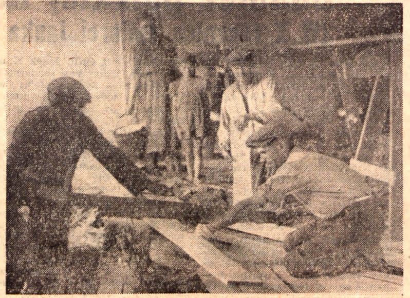
W trosce o warunki bytowe robotników Miejska Rada Narodowa przeznaczona duży fundusz na remont mieszkań. Na zdjęciu: gruntowny remont mieszkania robotnika ob. Wardy przy ul. Stalingradzkiej 55. Już wkrótce rodzina ob. Wardy otrzyma nowo piękne mieszkanie. (Foto Wier.)
