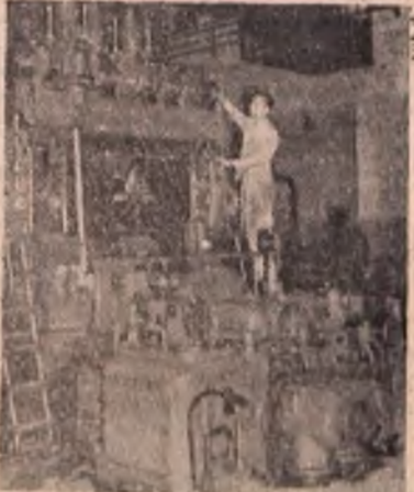
Na zdjęciu: maszynista turbinowy Edward Sądlich obsługuje nową turbinę.
