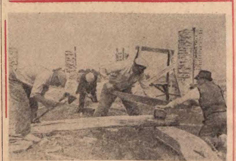
Na fundamentach owczarni pracuje grupa budowlana pod kierownictwem Stefana Tymejczuka
