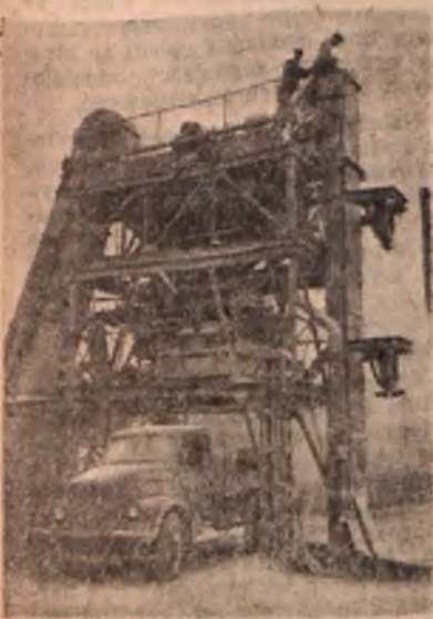
Produkcyjne zaplecze budowy Pałacu Kultury i Nauki im. J. Stalina, to techniczna baza w Jelonkach, do której stale przybywają ze Związku Radzieckiego transporty z materiałami. Tu również znajduje się wytwórnia betonów i zapraw, wytwórnia armatury i asfaltu, stolarnie i tartak, silownia, warsztaty samochodowe, magazyny itd. Na zdjęciu: automatyczne ładowanie samochodu betonem. (CAF fot. Dąbrowiecki)
