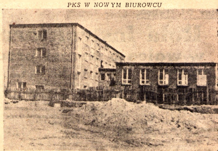
Olbrymi biurowiec PKS na Bronowicach został już oddany do użytku przez Lubelskie Przemysłowe Zjednoczenie Budowlane. W gmachu tym oprócz biur mieścić się będą w dobudowanym skrzydle: piękna świetlica i nowoczesna stołówka, zaś w podziemiach — łazienki i prysznice dla kierowców i monterów samochodowych, którzy w końcu września rozpoczną pracę w jednej części budującej się hali zajezdni PKS. (Fot. R. Sad.)
