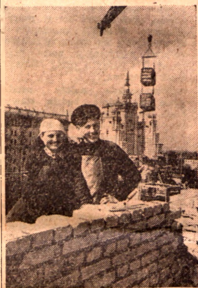
Moskwa otrzyma w roku bieżącym 36 nowych szkół, 40 budynków na przedszkola i żłobki, 15 gmachów szpitalnych i 800 tysięcy m kw. powierzchni mieszkalnej. Na zdjęciu: budowniczowie nowej Moskwy — murarz Gurij Siedukow i pomocnik murarska Aleksandra Woronkowa przy budowie domu przy ul. Czajkowskiego. (Fot. — CAF)
