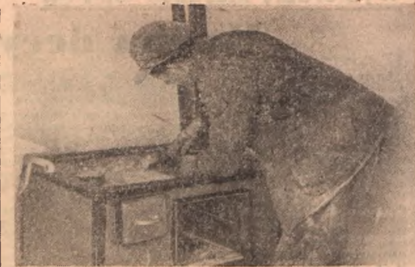
Zdzisław Pikul, przodownik pracy wykonujący 150% normy pełnią wartość 1-Majową podczas wykańczania bloku Nr 7 na osiedlu robotniczym ZOR — Bronowice. Na zdjęciu: Pikul w czasie instalowania kuchenki typu „Jawor”.
