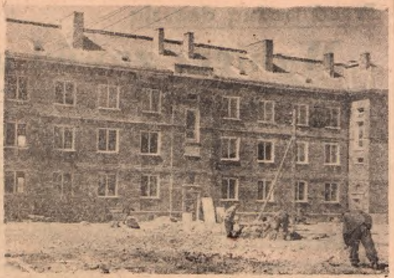
Dzięki zobowiązaniu produkcyjnym podjętym na cześć 1-go Maja — załoga ZBM zatrudniona przy budowie osiedla robotniczego ZOR — Bronowice oddała 146 izb mieszkalnych dla świata pracy. Na zdjęciu: fragment jednego z oddanych do użytku w dniu Święta Pracy budynków mieszkalnych, bloku Nr 26, który wykończony został bez usterek.
