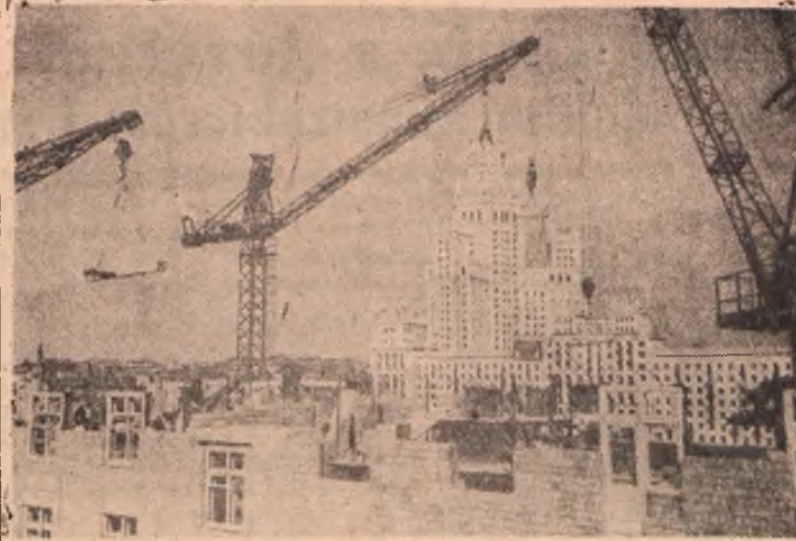
W roku bieżącym oddane zostaną w Moskwie do użytku ludzi pracy domy o powierzchni mieszkalnej 800 000 m kw. Na zdjęciu: budowa czternastopiętrowego domu mieszkalnego na wybrzeżu M. Gorkiego. W głębi — wieżowiec na wybrzeżu Kotelniczskim. (Fot. — CAF)
