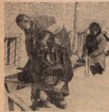
Uczennice I klasy Technikum Budownictwa Przemysłowego zobowiązały się wykonać betonowanie wokół szkoły. Na zdjęciu: uczennice przy pracy.
