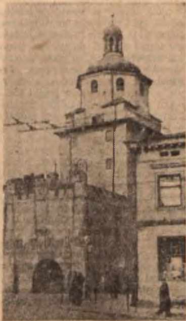
Jeden z najstarszych zabytków Lublina, Brama Krakowska — stanowiła przed laty główny bastion warownego grodu.
