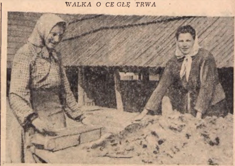
St. Fijałkowska i L. Karkuszevska, robotnice przodującej cegielni „Rekord“, przy pracy.
