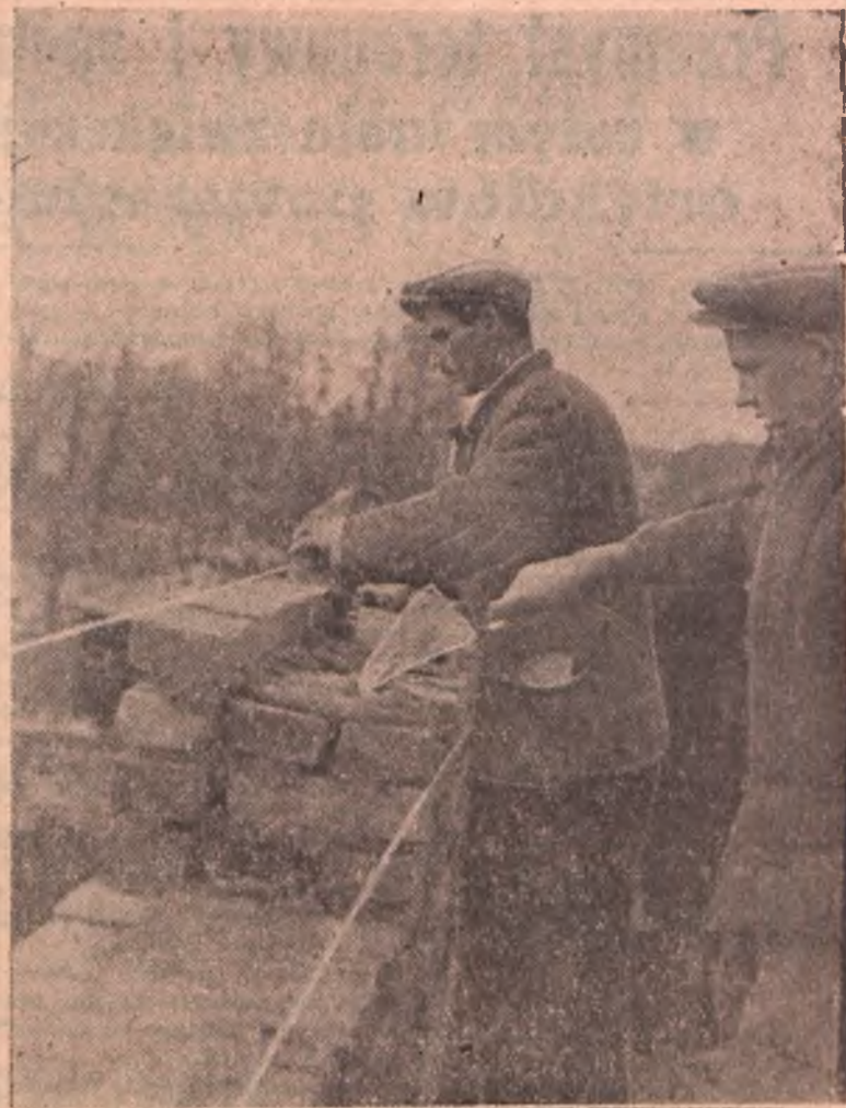
Zygmunt Mamej, którego brygada murarska pracuje na budowie 151/53 (prowadzonej przez ZBM) wyrabia ponad 200% normy mimo ciężkich warunków atmosferycznych. Zygmunt Mamej zobowiązał się ze swą brygadą wykonywać 165% normy i stale to zobowiązanie przekracza.
