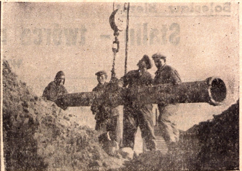
Młodzieżowa brigada Zjednoczenia Instalacji Przemysłowych zatrudniona na budowie FSC realizuje swe zobowiązania. St. Swiszczy, Wł. Chmiel, E. Sionko i brigadier Wł. Misztal (z prawej strony) ostatnio wykonali 270% normy zakładając rury wodociągowe przy pomocy dźwigu.
