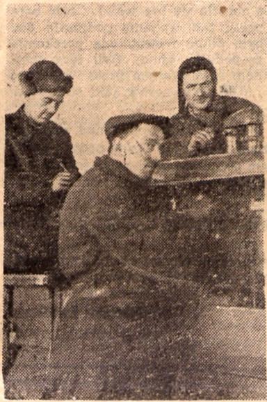
W POM Wierzbica (pow. Chełm) remonty maszyn dobiegają końca. Siewniki, traktory, jak również i inne maszyny rolnicze z chwilą nastania wiosny będą gotowe do rozpoczęcia pierwszych prac w polu. Na zdjęciu: przodujący mechanik Bogumił Członek (pierwszy z prawej) wraz z pomocnikami Andrzejem Chwedorukiem i Janem Czachorą remontują traktor marki Zetor.
