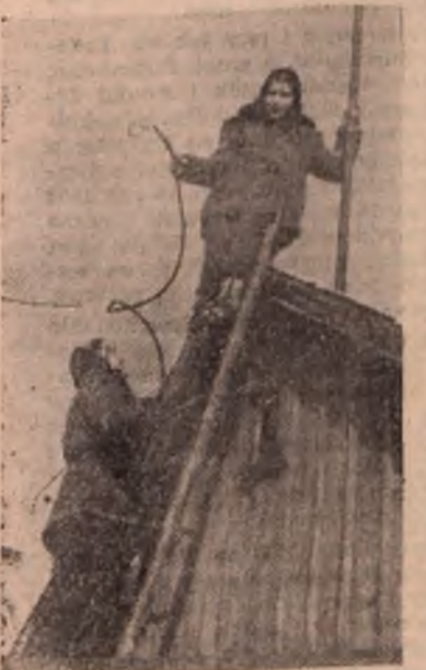
Józefa Osak i Danuta Szcześniak, które pochodzą ze wsi nauczyły się fachu. Widzimy je przy zakładaniu przewodów elektrycznych w gromadzie Zaklików (pow. Radzyń)
