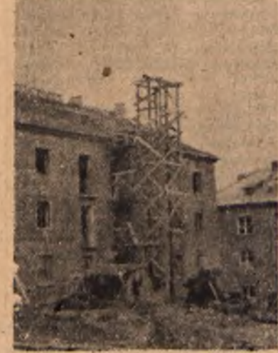
Lublin otrzymuje coraz więcej nowych budynków mieszkalnych. Na zdjęciu: fragment budowy ZOR — Zachód.
