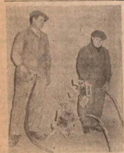
Instruktorzy Ministerstwa Budownictwa Przemysłowego Karol Obrók i Stanisław Rybak z kompletem urządzeń do mechanicznego zacierania tylników.
