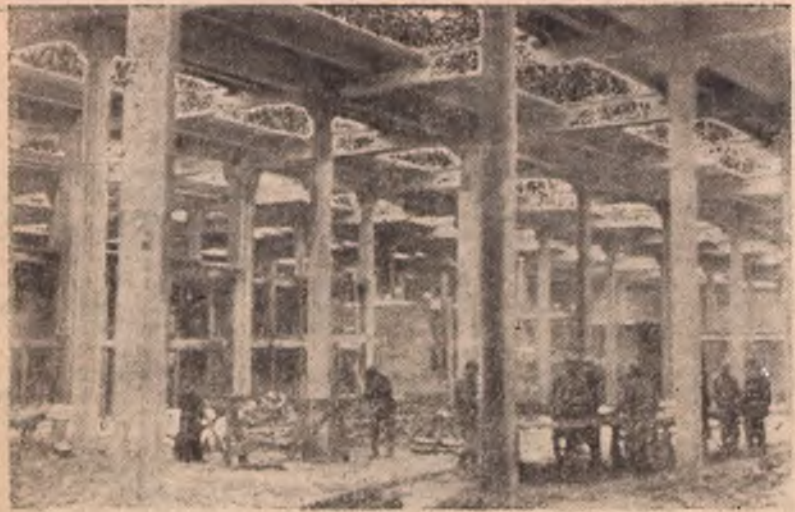
PKS w Lublinie ma ciężkie warunki pomieszczeniowe. Budynki są rozrzucone w różnych punktach naszego miasta. Obecnie jest na ukończeniu biurowiec, który już w najbliższych dniach będzie oddany do użytku. Obok niego powstają wielkie hale, w których przeprowadzać się będzie remont wozów. Na zdjęciu: fragment hali. (Foto K. Wierucki)
