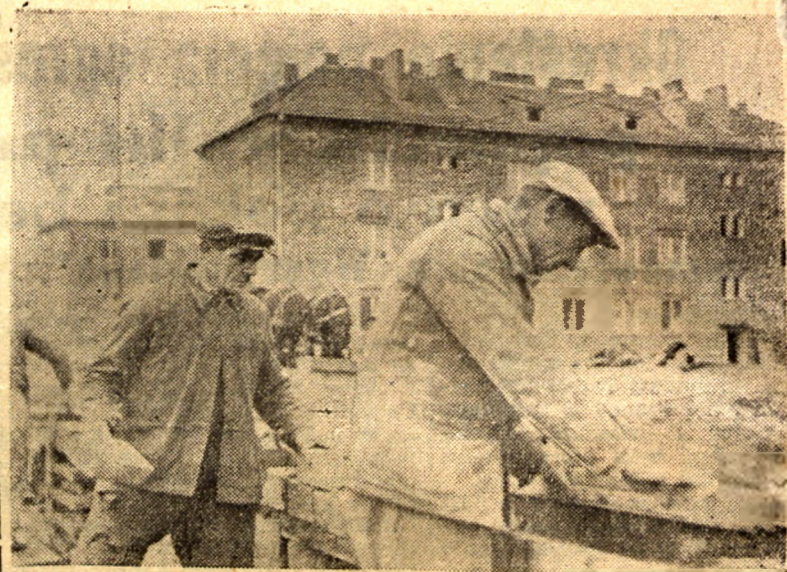
ZOR Zachód rozbudowuje się. Na zdjęciu: murarze St. Głowacki i St. Rajewski przy pracy na bloku Nr 6.
