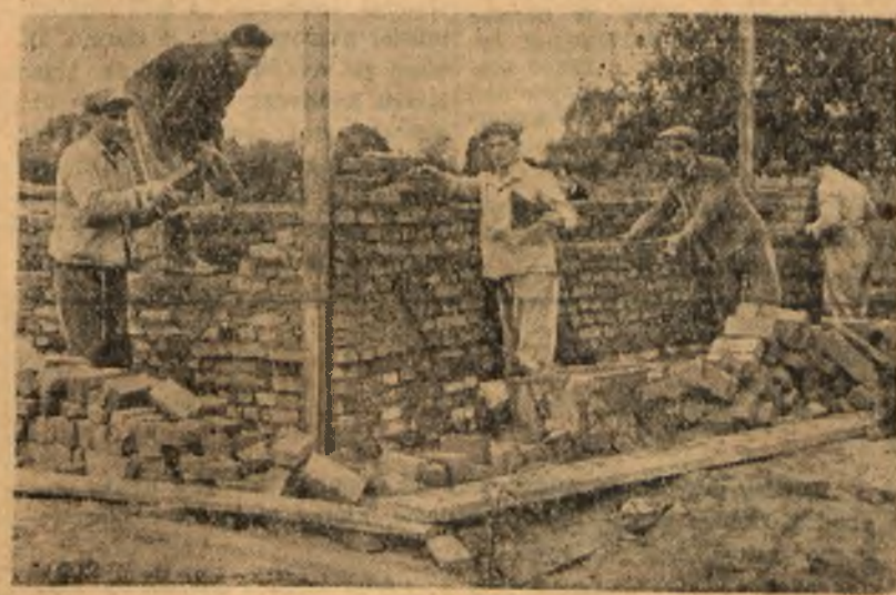
Już stoją mury. Wnet zostaną pokryte dachem
