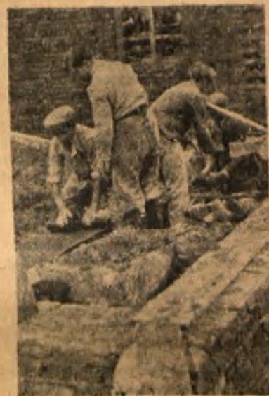
Słuchacze Technikum nie oszczędzają sił przy budowie domków spółdzielczych.
