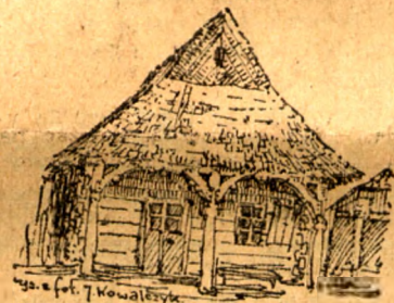
Goraj. Nieistniejący już dom podcieniowy
