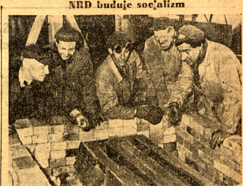
W ciągu kilku ostatnich miesięcy powstała pierwsza część nowoczesnej hali budowy okrętów w Warniunde (NRD). W końcu br. hala ta będzie całkowicie wykończona. Można w niej będzie równocześnie budować 4 okręty o tonażu od 9 500 do 12 000 ton. — Na zdjęciu: brygada spawaczy, zatrudnionych przy budowie stocznii omawia nową metodę spawania inżyniera Ploetzta, diżelki które złączą szruby i części maszyn mogą być odnawiane. (CAF)
