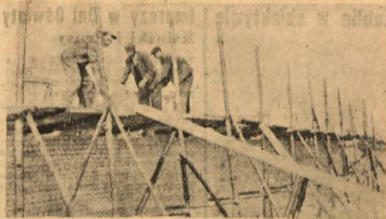
W spółdzielni produkcyjnej w Zagrodzie (pow. krasnostawski) członkowie postanowili wybudować sposobem półgospodarczym oborę. Budowa, rozpoczęta przed dwoma tygodniami, jest już na ukończeniu. Na zdjęciu: tow. Detiuch, Najda i Herbut podczas pracy na budowie. (Do artykułu niżej). (fot. „Sztandar Ludu“ — J. K.).
