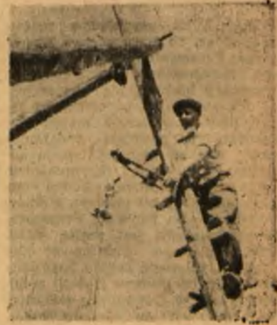
Spółdzielcy budują nową studnię...
