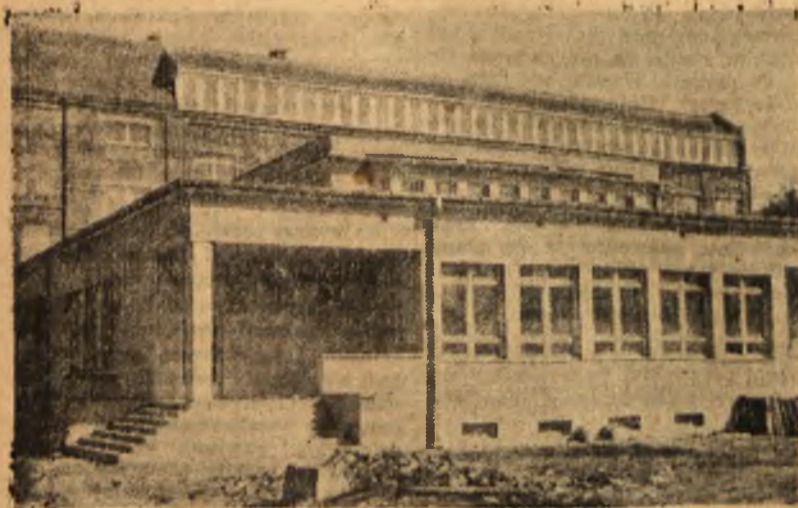
Załoga Gdańskiego Przedsiębiorstwa Budowlanego zobowiązała się ukończyć na dzień 1 Maja budowę szpitala dziecięcego w Gdańsku. Na zdjęciu: nowowubudowany gmach szpitala z polikliniką na pierwszym planie. CAF. — fot. Kosycarz.
