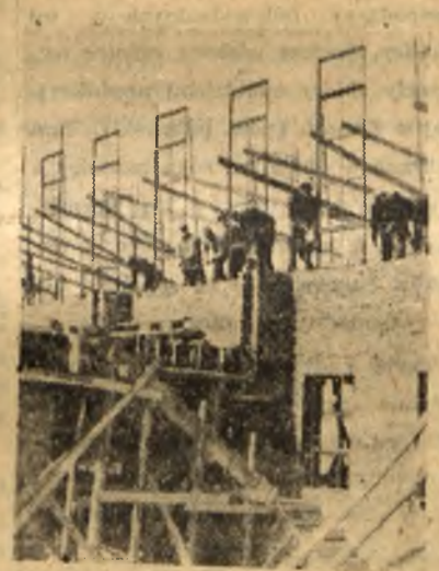
Rosną pierwsze budynki w cementowni Rejowiec II. — Na zdjęciu: hala warsztatowa.
