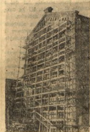
Stara, całkowicie zrujnowana cukrownia w Nieledzie przeobrazi się w nowoczesną, piękną fabrykę.
