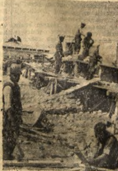
40 dwurodzinnych domków dla przodowników pracy powstaje przy Cementowni Rejowiec II.
