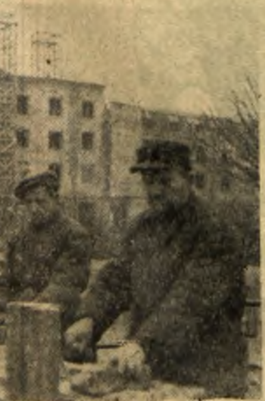
Na terenie Fabryki Samochodów Ciężarowych im. Bolesława Bieruta w Lublinie rośnie wielki hotel robotniczy.
