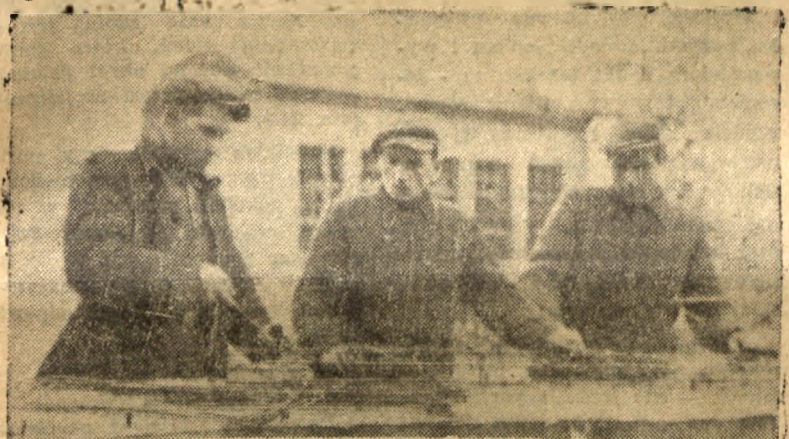
Brygada St. Ciuryńska pracuje przy budowie kombinatu tłuszczowego w Bodaczowie. Ostatnio wykonuje ona stale ponad 300% normy. Na zdjęciu: St. Ciurysek, F. Kisielniński i Piróg przy pracy.
