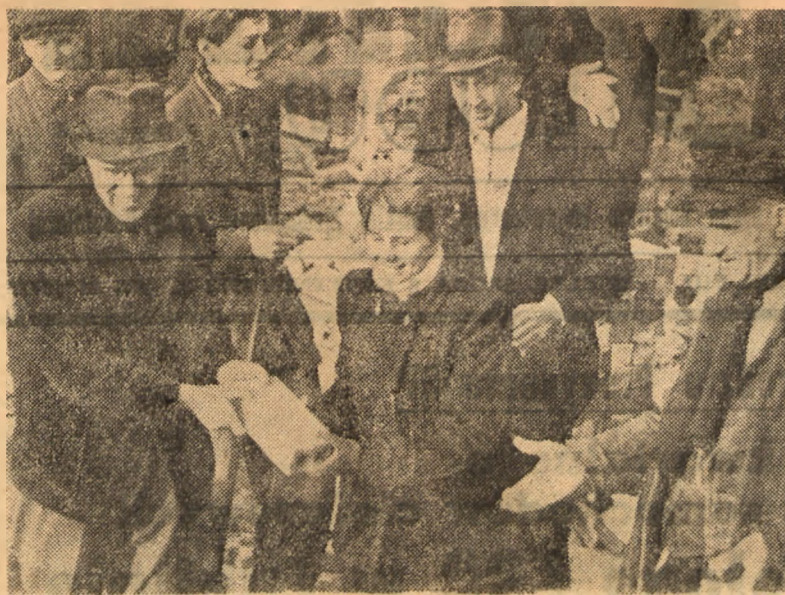
W odbudowie Berlina biorą udział wszyscy mieszkańcy NRD. Ostatnio położono kamień węgielny i rozpoczęto budowę fundamentów pod pierwszy dom mieszkalny bloku E — południe. W pracy pomagał premier Grotewohl i jego żona (na zdjęciu pierwszy od lewej).
