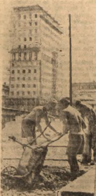
Junacy Lubelszczyzny przy budowie nowej Warszawy.
