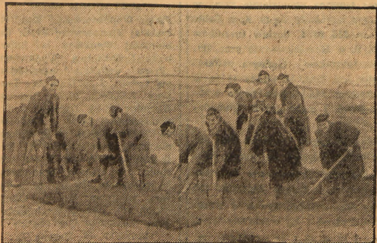
Grupa junaczek SP z hufca przy Gimn. i Lic. M. Sobolewskiej pracuje ochotczo przy budowie Dzielnicy Uniwersyteckiej. — Radosne uśmiechy na twarzach świadczą o tym, że pracę tę wykonują z zadowoleniem.
