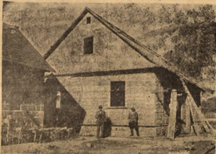
Na zdjęciu ściana szczytowa budującego się w Leśnej Podlaskiej domu ob. Harasimiuka z płyt słomianych, wykonanych przez ob. Mironczuka
