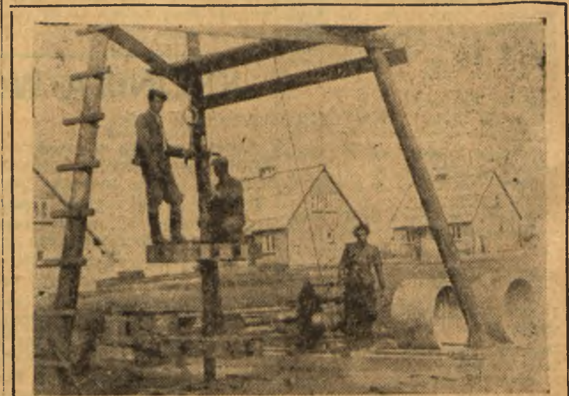
Spółdzielcy w Boratynie budują nową studnię.
