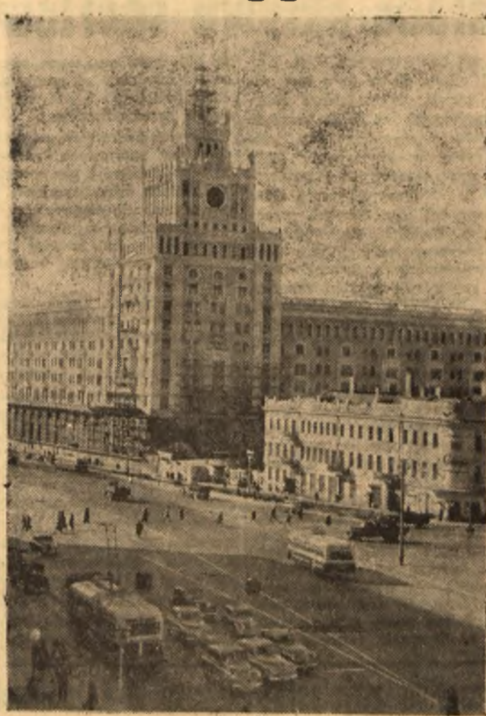
Związek Radziecki jest krajem nie tylko wszechstronnego rozwoju gospodarczego, lecz także wspaniałego nieznanego w państwie kapitalistycznym budownictwa. Zdjęcie przedstawia końcowe prace przy budownictwie hotelowym na ulicy Sadowej w Moskwie. 7 piętrowy budynek wylania się z rusztowań. Wieżowiec o wysokości 73 metrów, upiękaszony kolumnami i obeliskami, widoczny jest daleko z różnych punktów miasta.
