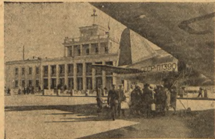
Na centralnym lotnisku w Moskwie.
