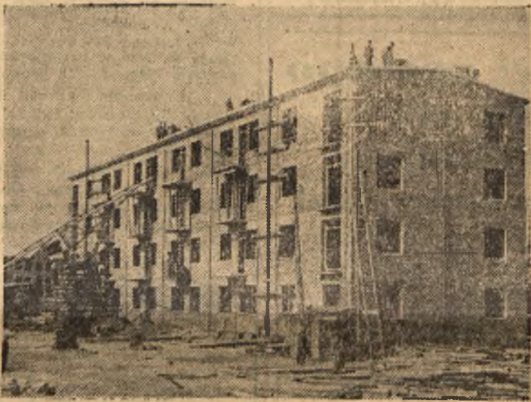
Budowa domu szybkościowego na Mokotowie została zakończona po 13 dniach. Zainstalowano centralne ogrzewanie, wodociągowe i balkony. Dnia 3.IX br. o godz. 13-ej odbyło się uroczyste zakończenie robót.
