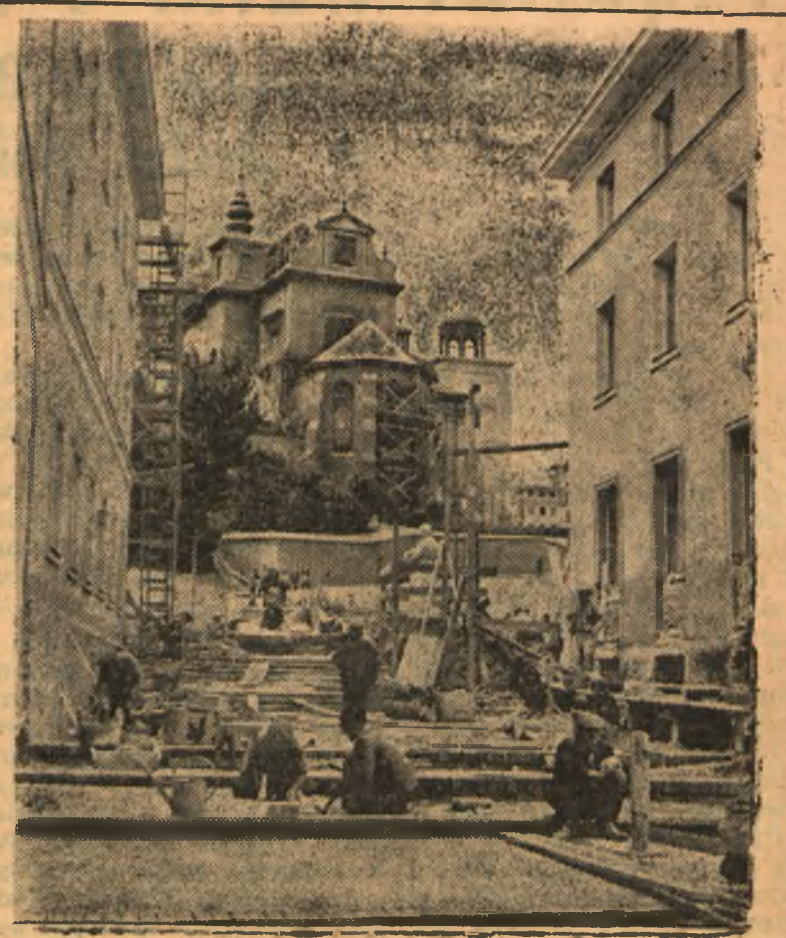
Trasa W-Z została wczoraj oddana dla ruchu. Na zdjęciu ostatnie prace przy budowie trasy: budowa jezdnii na Mariensztadzie. W głębi widoczny odbudowany kościół Św. Anny
