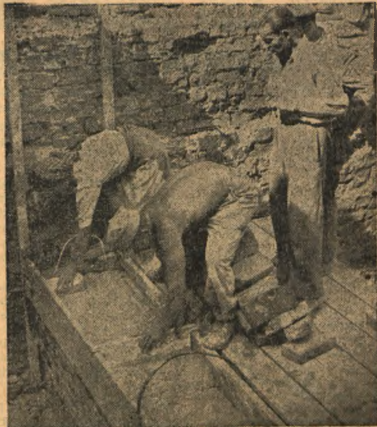
Majster murarski, ob. T. Głowacki, pracujący przy budowie gmachu Ministerstwa Skarbu w Warszawie, zastosował przy murowaniu ścian szablon z desek. Szablon pozwala murować nieregularnie ułożonymi cegłami bez użycia pionu i ułatwia równoległe rozkładanie zaprawy i cegieł. Na zdjęciu — podręczni Irene Pazio i St. Domański układają cegły w głębi stoł majster Głowacki
