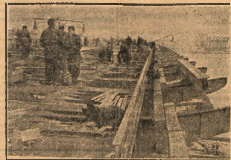
Zakładanie kabli elektrycznych na moście Śląsko-Dąbrowskim w Warszawie.
