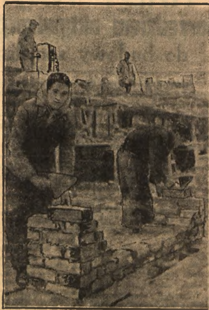
Przy budowie osiedla robotniczego „Młynów” w Warszawie na Woli pracują jako murarze trzy kobiety.
