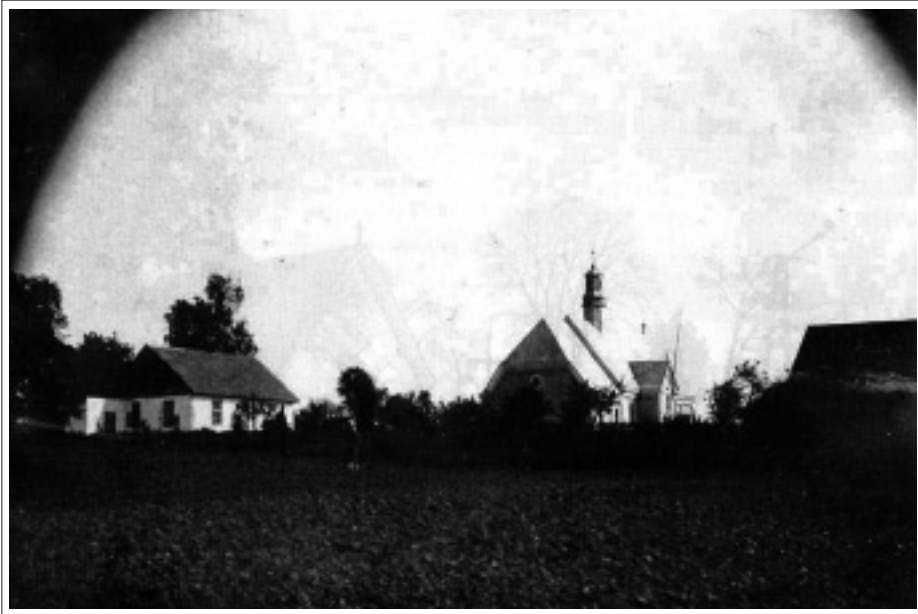
Ogólny widok na gospodarstwo kościelne w Ostrówku po przebudowie świątyni. Widoczna plebania, kościół i budynki gospodarcze, 1930 r., Archiwum parafii Ostrówek
