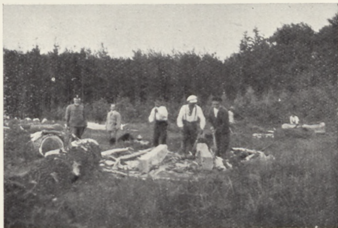
Wyrób podkładów w Zielonce pod Poznaniem
