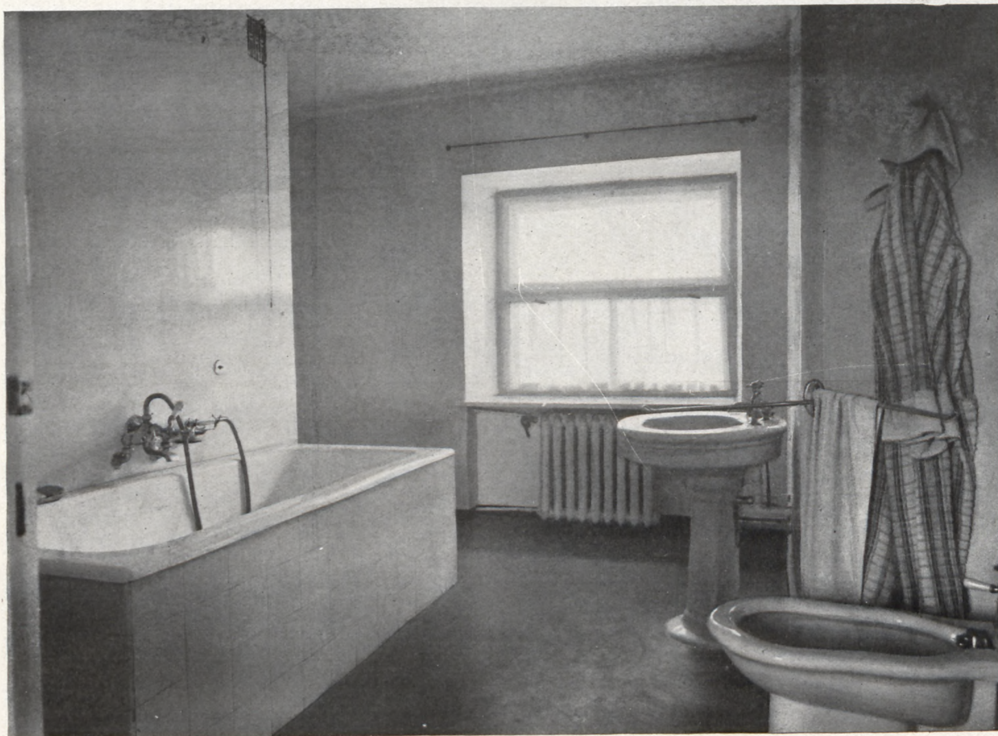
87. Proj. Arch. Nina i Józef Jankowscy (W-wa) — łazienka. W łazience wanna, umywalnia, bidet, klozet angielski z klapą i miejsce na wanienkę dziecięcą. Orientacja — północno wschodnia. Ściany lakierowane na biało. Instalację wyk. inż. Cz. Zarzecki (W-wa). Wyroby ceramiczno-sanitarne produkcji Zakładów Ceramicznych „Józefów” (w Czeladzi). Wanna „K” kwasoodporna — Zakładów Przemysłowych „Kamienna — Jan Witwicki”.
