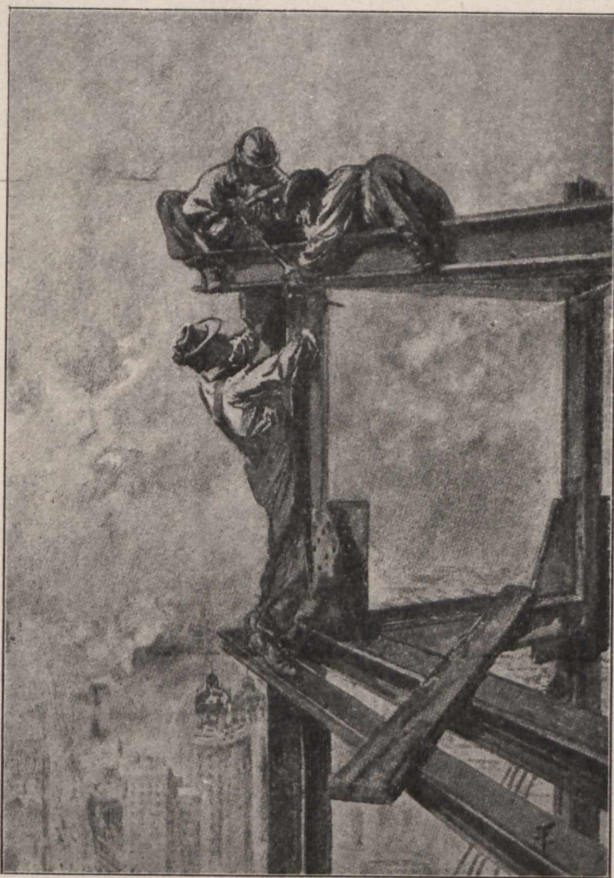
Praca na rusztowaniu w obłokach.
