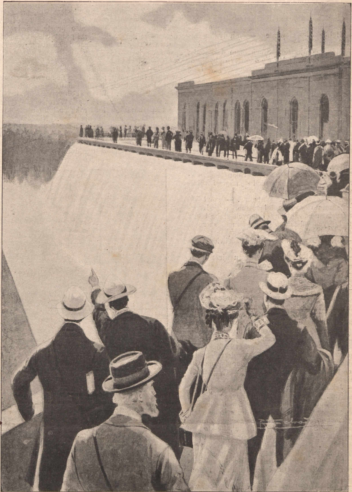
Zwiedzanie zakładów elektrycznych, opartych na użytkowaniu olbrzymiego spadku wody w Vizola (kanton tessyński, Szwajcarya).
